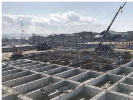
⑦手前は型枠撤去後。奥は撤去中です。
