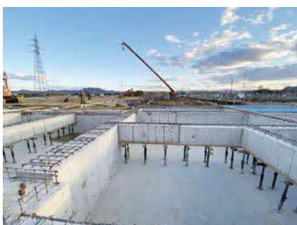
⑦型枠撤去後の様子です。
