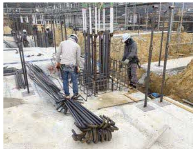
④中央の背の高い鉄筋は、この上に鉄骨柱を取り付けるため、先端にはボルトがついています。
