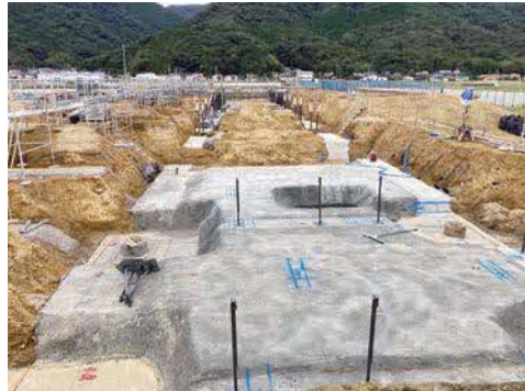
③砕石の上にコンクリートを敷設した様子です。
