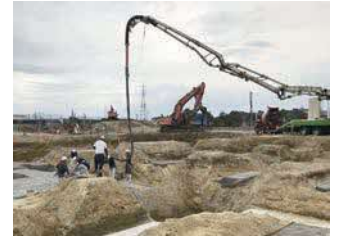
③写真右から中央に伸びているのが、コンクリートを流し込む機械です。
