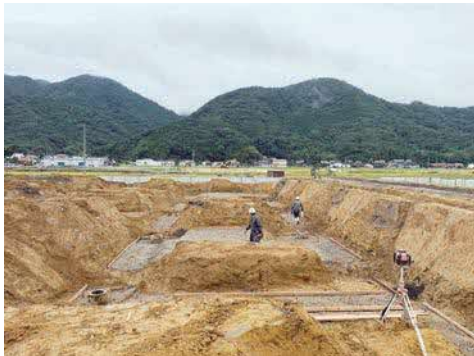
①・②地盤を掘削し、砕石を敷設する様子です。
