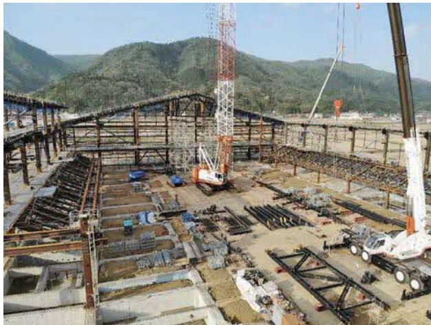
■メインアリーナの作業風景です。写真両側の斜めに鉄骨が組んであるところが観客席になります。
