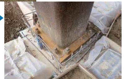
■鉄骨を設置する基礎です（左）。下の写真が鉄骨を設置した様子です。鉄骨はボルトで固定しますが、鉄骨のサイズにより、ボルトの数が違います。
