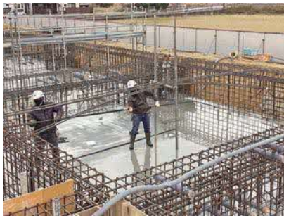
④鉄筋組立の様子です。
