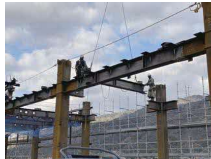
■鉄骨はクレーンで吊り上げ、1本ずつ取り付けます。
