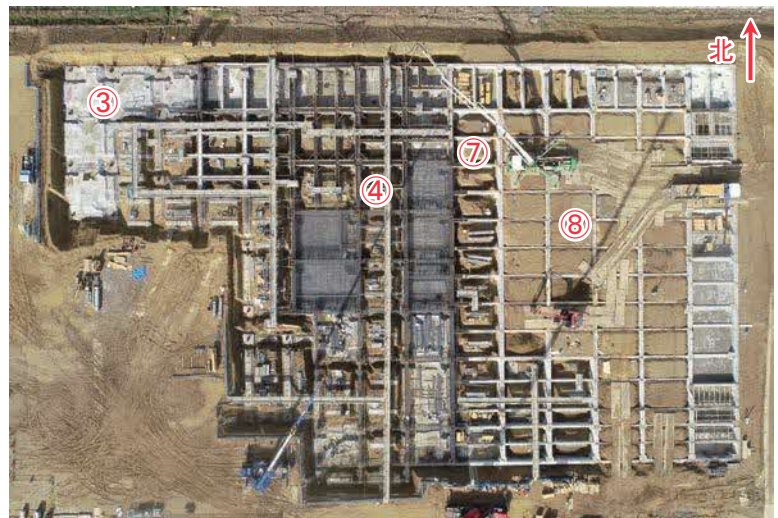
④中央の背の高い鉄筋は、この上に鉄骨柱を取り付けるため、先端にはボルトがついています。
