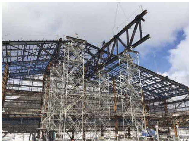
■両アリーナとも競技エリアには柱がありませんので、梁を支える受け材が必要です。写真はこの受け材の設置作業の様子です（写真右の赤丸部分）。
