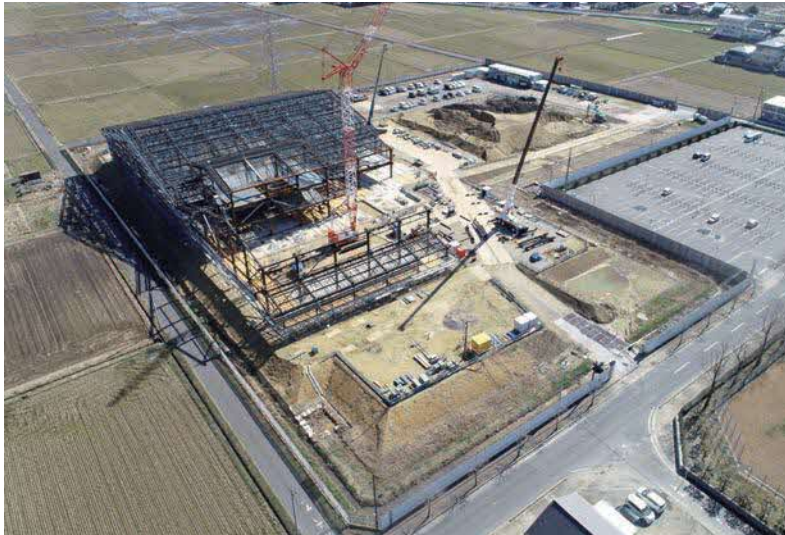
■2月27日時点の様子です。メインアリーナと中央通路部分が完成し、サブアリーナの鉄骨組み立てをしています。
