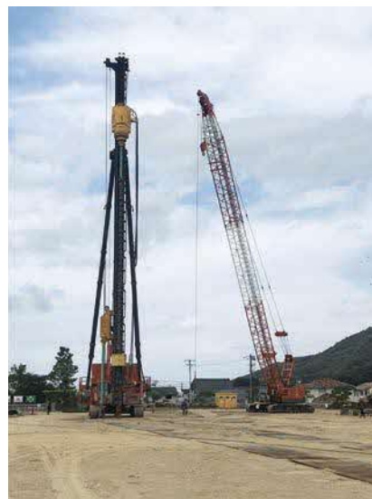
■左が杭打機で、右がクレーンです。高さは約40mあります。
