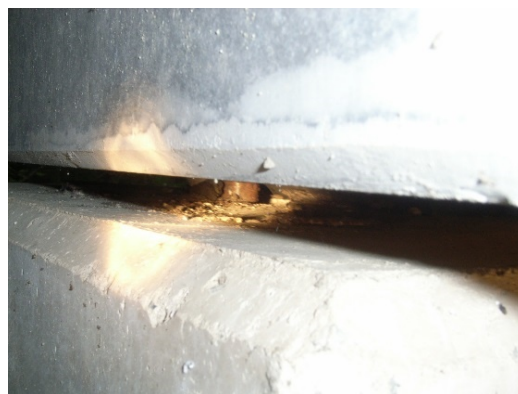
鉛直アンカーバーの腐食(支承)
