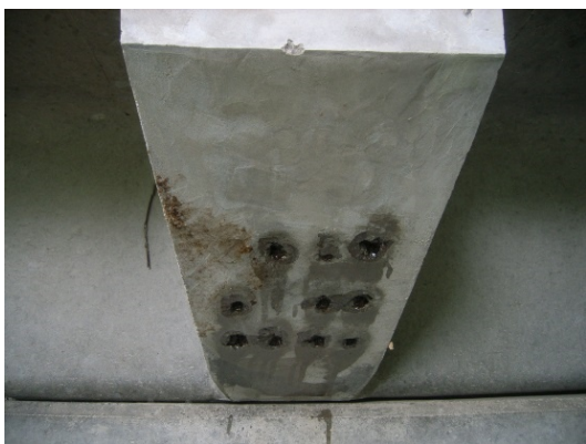
PC 鋼材定着部の鉄筋露出(主梁) 錆汁を伴う遊離石灰、ひび割れ(山側受台)
