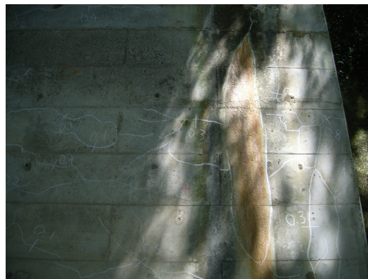
PC 鋼材定着部の鉄筋露出(主梁) 錆汁を伴う遊離石灰、ひび割れ(山側受台)
