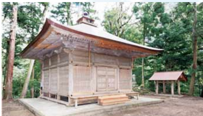
修理が完了した開山堂（手前）と開山廟（奥）
