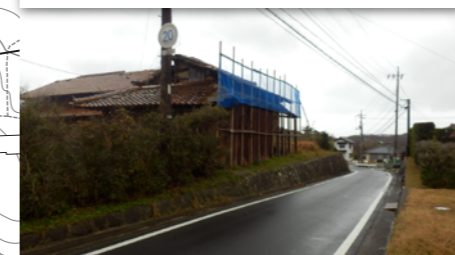
避難道路危険箇所
