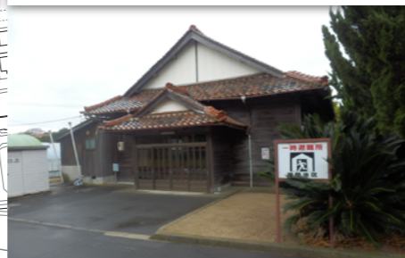
一時的な避難所 公民館 標高 36.0m 木造のため、地震規模によっては使用できない
