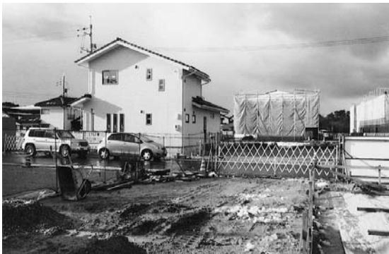
開発の進む出雲徳洲会病院東側付近
