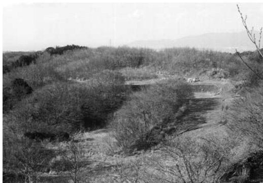
次期可燃ごみ処理施設建設予定地（古志採石場跡地内）
