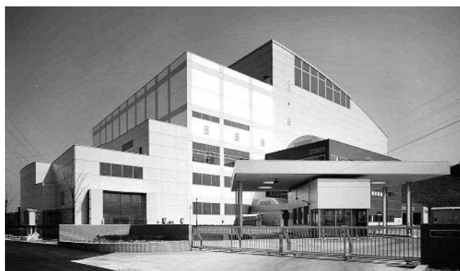
耐用年数を迎え改修が必要になった出雲エネルギーセンター
