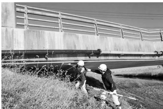
道路・橋の定期点検を行う市職員
