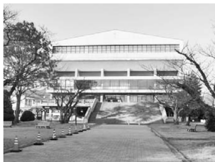
老朽化した出雲体育館
