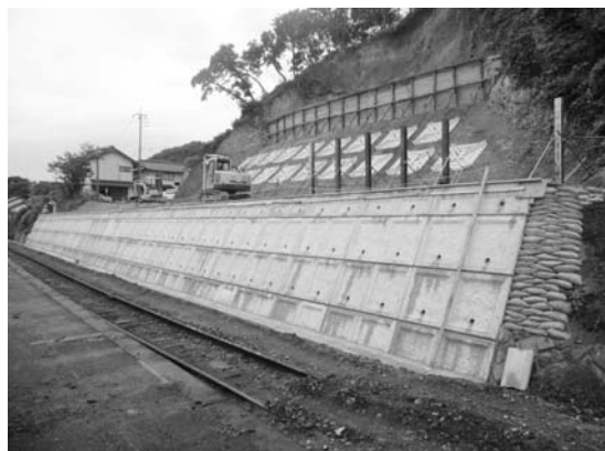
復旧工事の進む柳谷田儀駅前線
