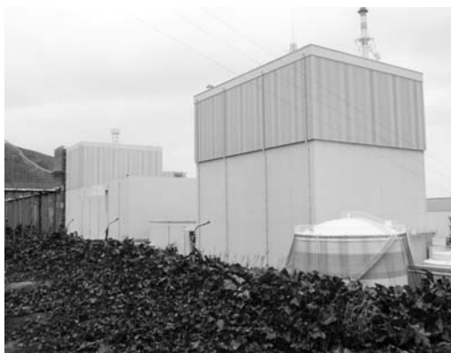
廃炉を待つ島根原発1号機
