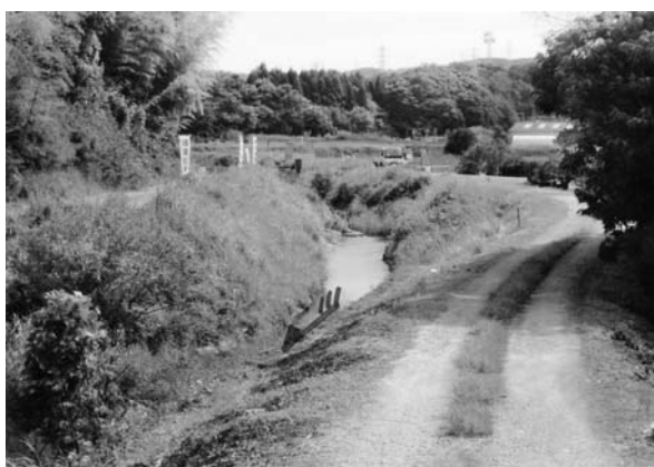
改修が急がれる十間川
