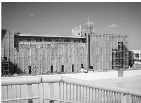
耐震改修中の学校施設
