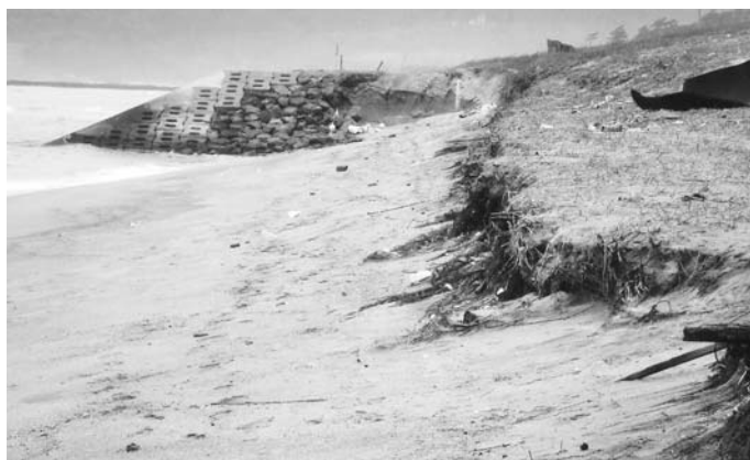
浸食が進む砂丘海岸（大社町杵築西湊原）
