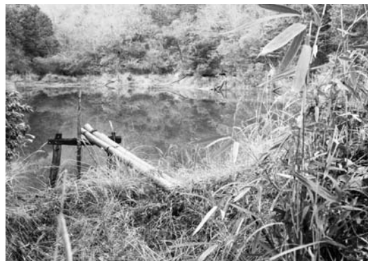
貯水能力を大幅に失った溜池
