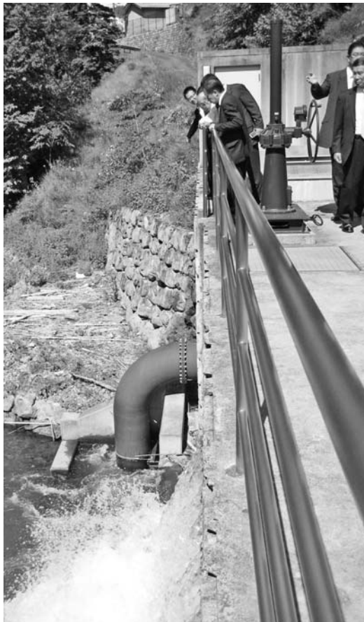
小水力発電所（栲原町）
