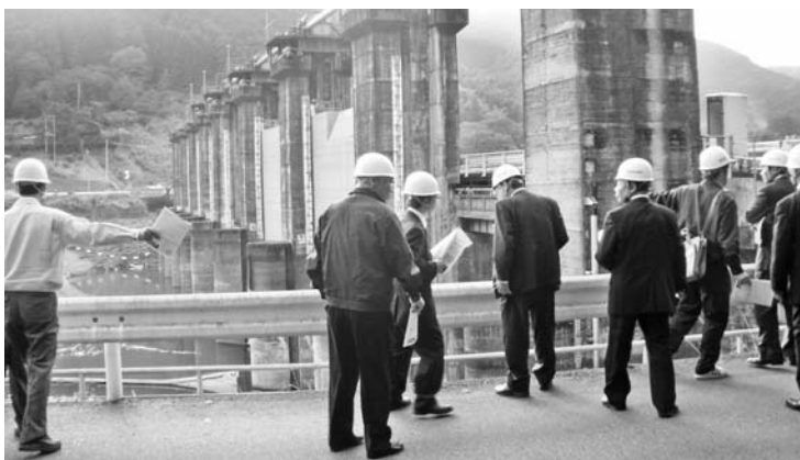
撤去中の荒瀬ダムを視察
