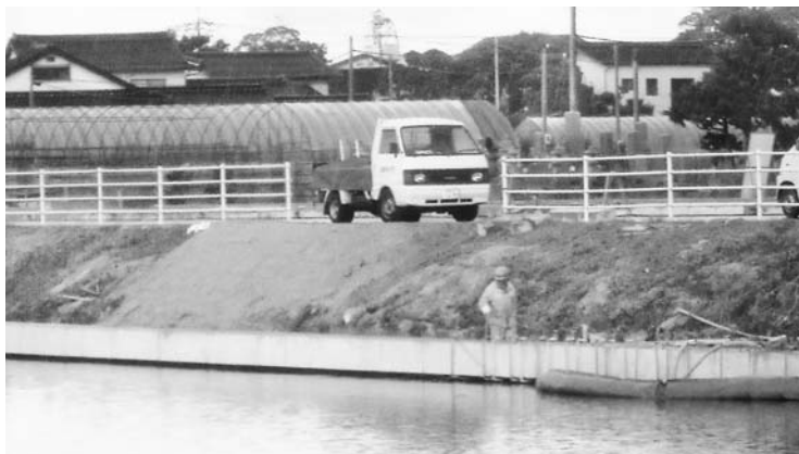
急ピッチで護岸工事が進む新内藤川下流部
