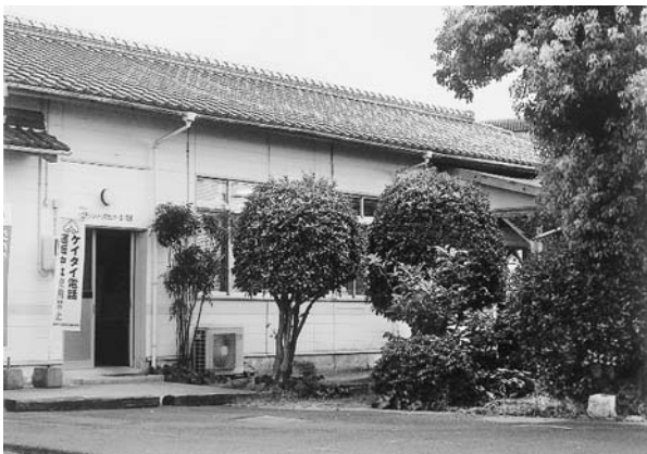
シルバー人材センター斐川支所（JR 荘原駅構内）
