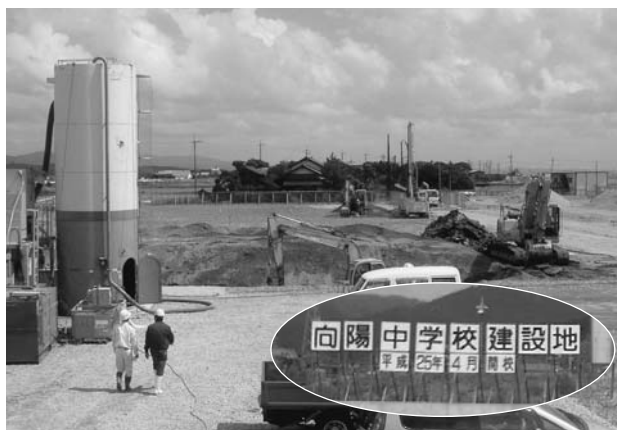
向陽中学校校舎・屋内運動場建設工事の着手
