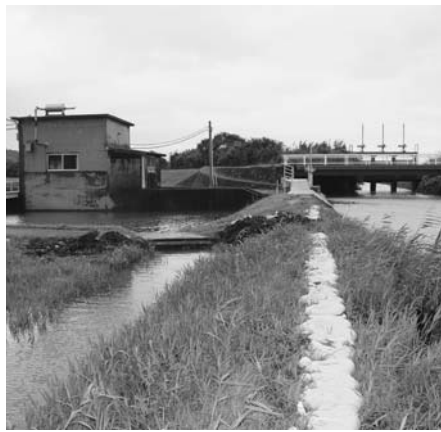
老朽化した排水機場（園町）
