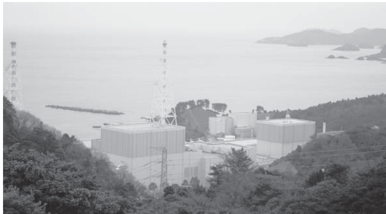
島根原子力発電所
