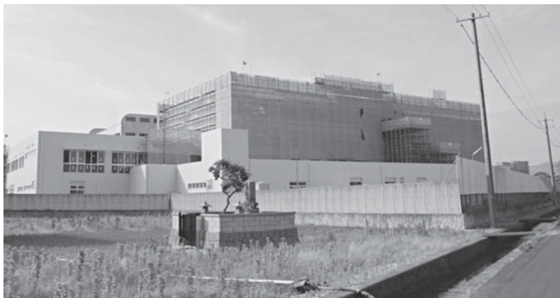
完成間近の総合医療センター
