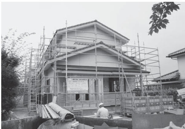
新築中の住宅
