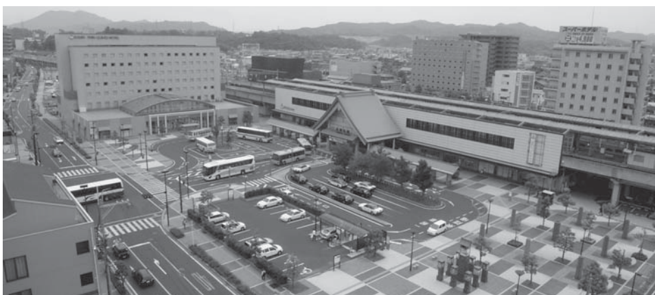
高架化された出雲市駅
