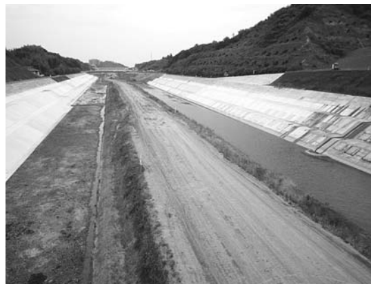
ほぼ完成の放水路
