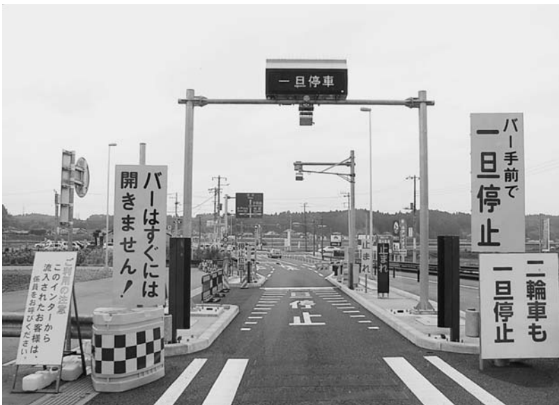
常磐自動車道の水戸北スマートインターチェンジ（ETC出口）
