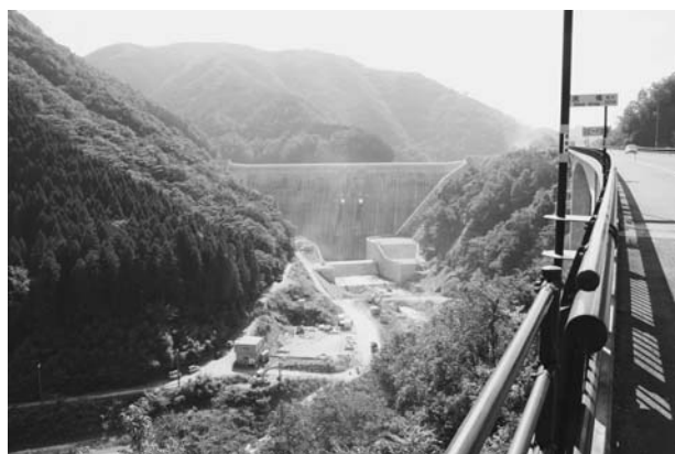
神戸川工業用水の水源となる志津見ダム（飯南町）
