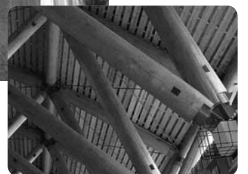
「スケルトンログ構法」で建設された小鴨小学校屋内運動場(倉吉市)
