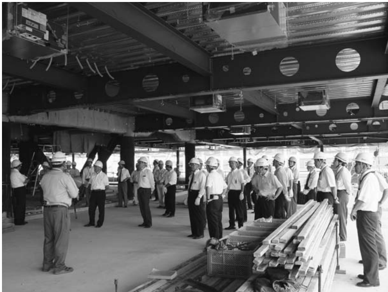
建設中の新庁舎を視察
