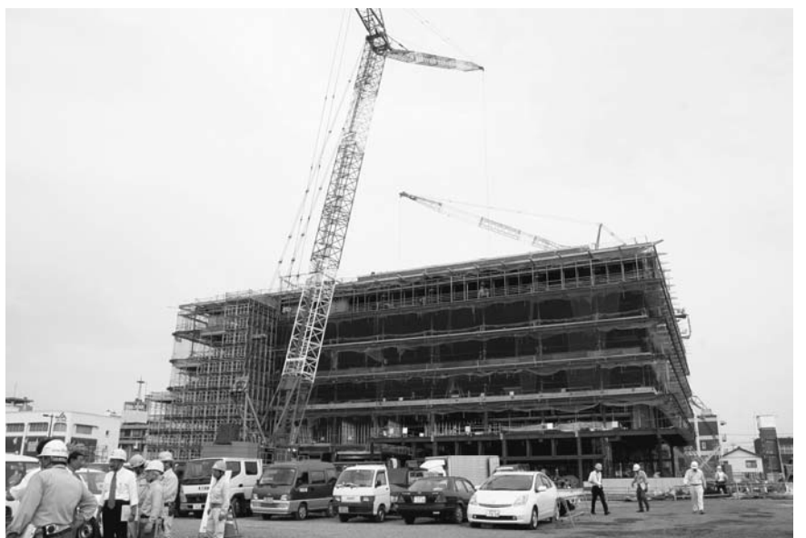
合併特例債を活用して建設中の新庁舎
