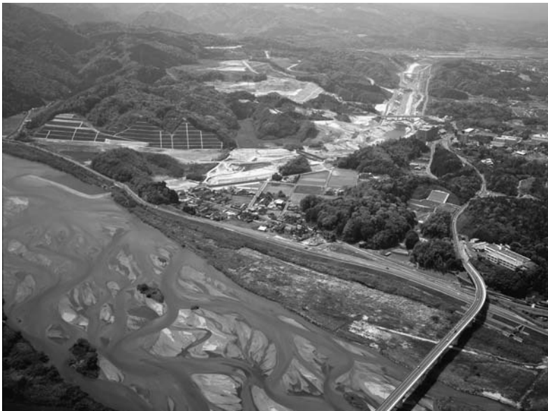
斐伊川から放水路を望む(写真提供:国土交通省 中国地方整備局 出雲河川事務所)
