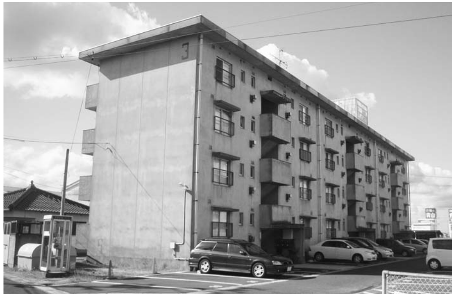
市営小山住宅
