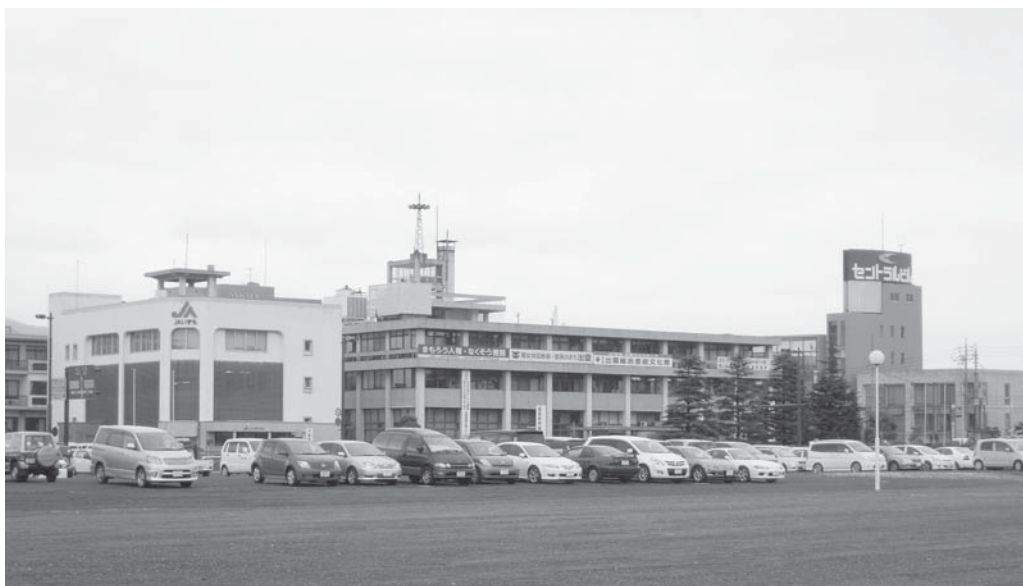
杭（くい）の撤去工事が行われる庁舎建設予定地（手前）と現庁舎
