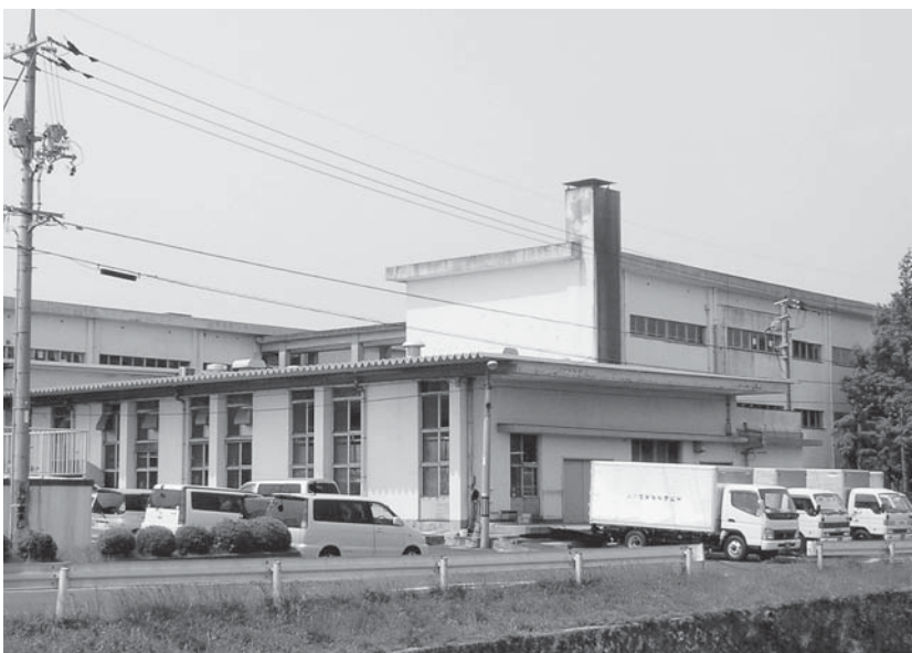
昭和42年に建設された平田給食センター
