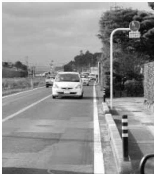
国道431号には歩道がなく危険な所がある
