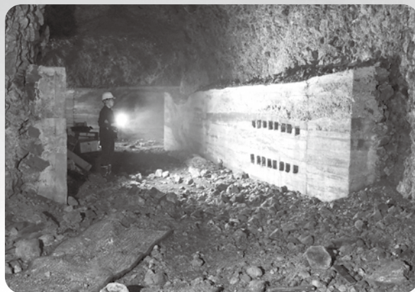
大社基地の魚雷調整場跡(斐川町神水)の内部 未完成のまま終戦を迎えた
