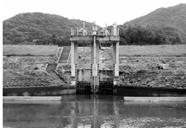
国営事業により整備された斐伊川右岸頭首工（斐川町出西地内）
