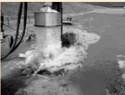
取水井戸の掘削のようす(イメージ)
