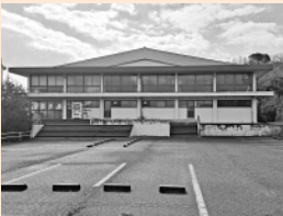
解体予定の旧斐川第 2 体育館
