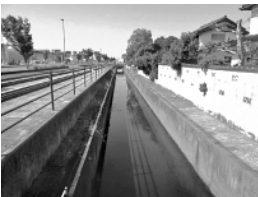
改修予定の水路(小山町地内)
