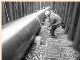
配管工事のようす
