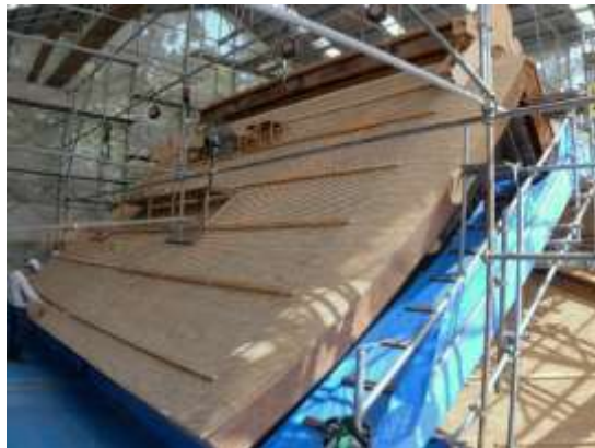
屋根葺き替え工事中の本殿
