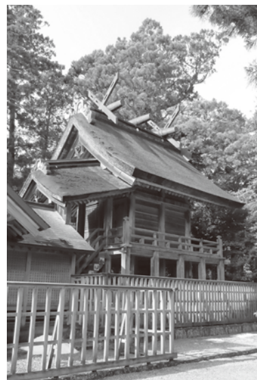
修理前の須佐神社本殿
