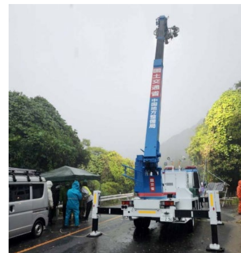
照明車 (松江国道事務所 保有) R6.7.10 日御碕地区道路崩落現場への派遣
