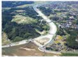
斐伊川放水路竣工 (平成25年6月)
