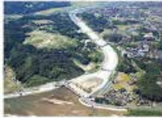
斐伊川放水路竣工 (平成25年6月)
