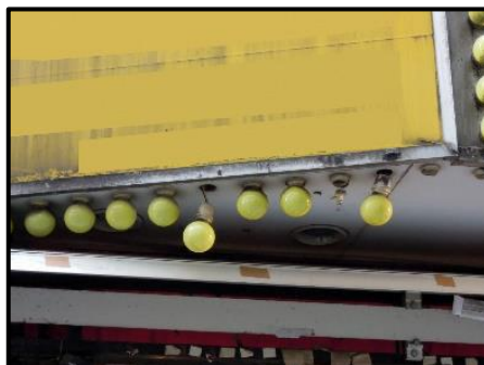
ソケットの破損
