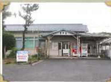
▲解体前の駅舎(平成31年4月) 斐川町シルバー人材センター 事務所がここにありました。
