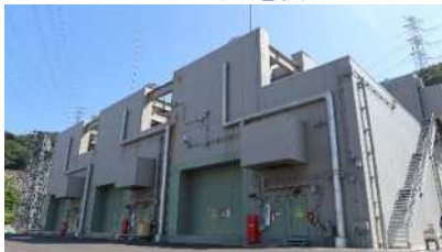
＜ガスタービン発電機（2台）＞
