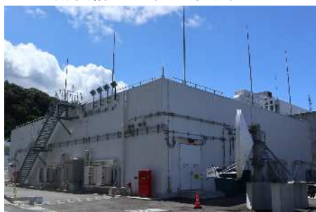
＜耐震構造の緊急時対策所＞
