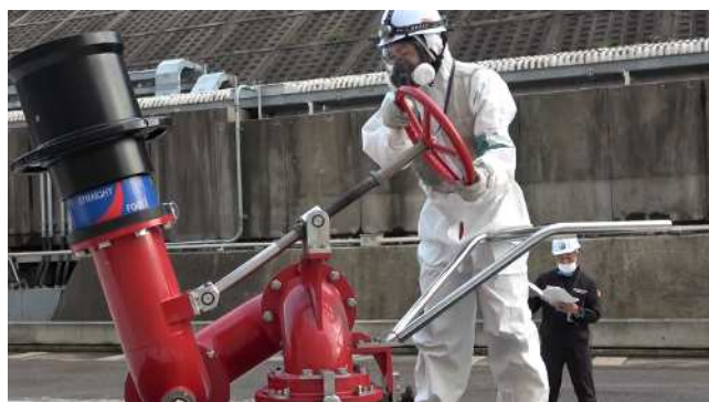
放水砲による放水準備
