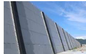
＜防波壁（海拔15m、延長1.5km）＞
