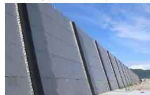
<防波壁(海拔15m、延長1.5km)>
