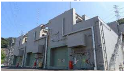
<ガスタービン発電機(2台)>
