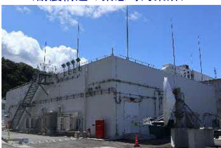
<耐震構造の緊急時対策所>
