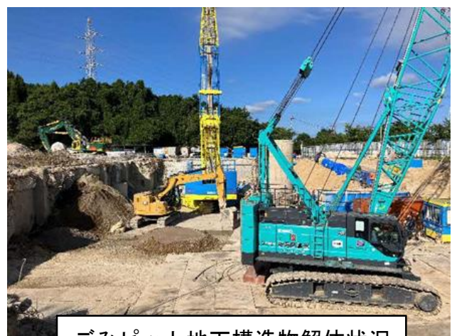
ごみピット地下構造物解体状況
