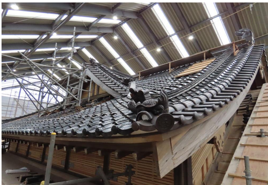
屋根の組立工事の状況（令和 6 年 8 月）
