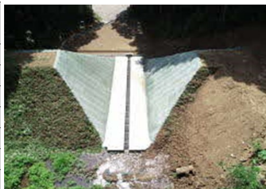
廃止工事(※2)の一例
