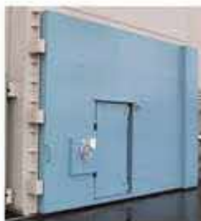
建物外側の水密扉
