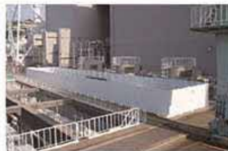
海水系ポンプエリアの防水壁
