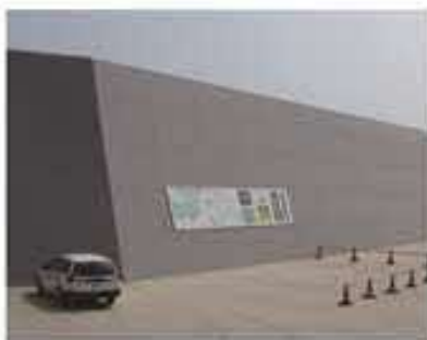
海側全域を囲んだ防波壁
