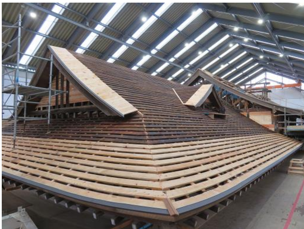
屋根の組立工事の状況（令和6年1月）
