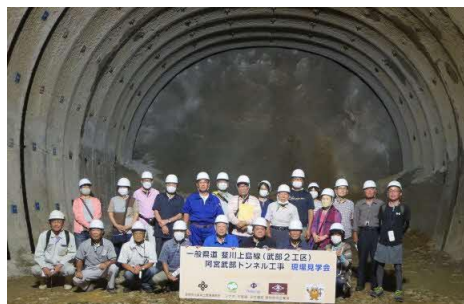
阿宮武部トンネル工事現地見学会
