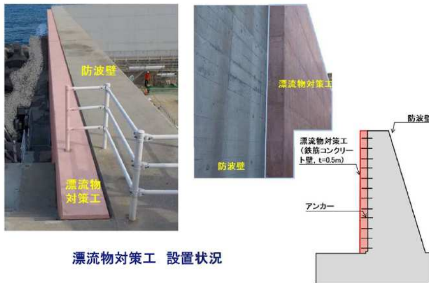
図3 漂流物対策工の設置状況
