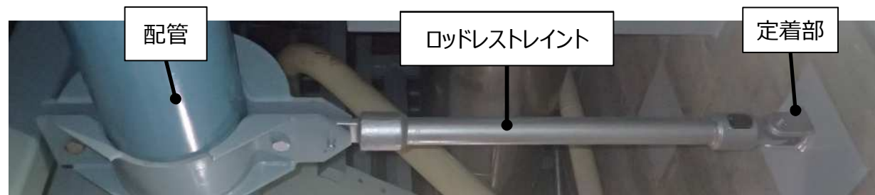
図4 ロッドレストレイントの設置例
