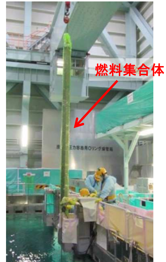
新燃料の引き上げ状況
