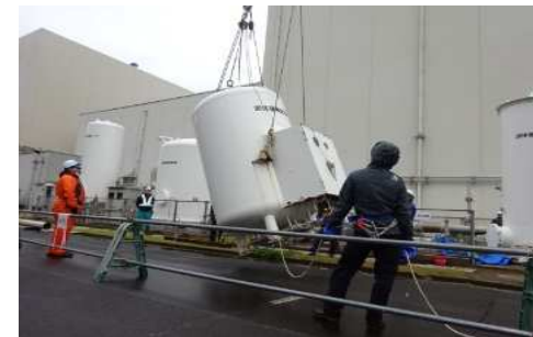
撤去作業の状況
