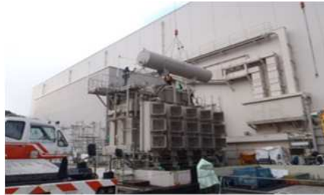
撤去作業の状況
