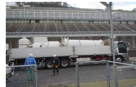
解体物の移送
