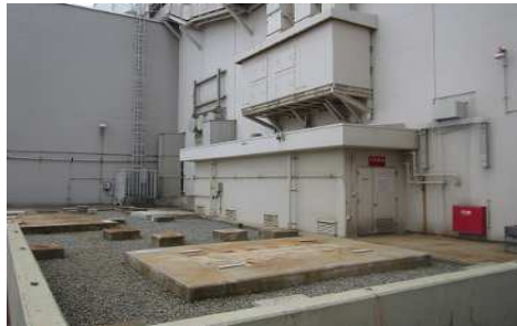
撤去作業後の状況
