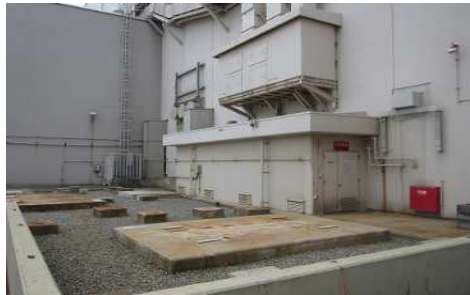
撤去作業後の状況
