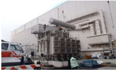
撤去作業の状況
