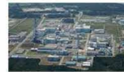
再処理工場 2024年度上期竣工目標
