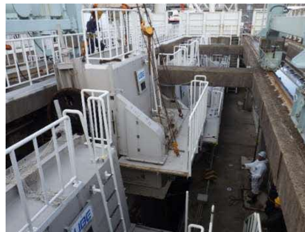
放射線管理区域外にある役目を終えた設備の解体撤去 (除じん機の撤去【完了】)
