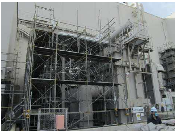
放射線管理区域外にある役目を終えた設備の解体撤去 (主変圧器等の撤去【完了】)
