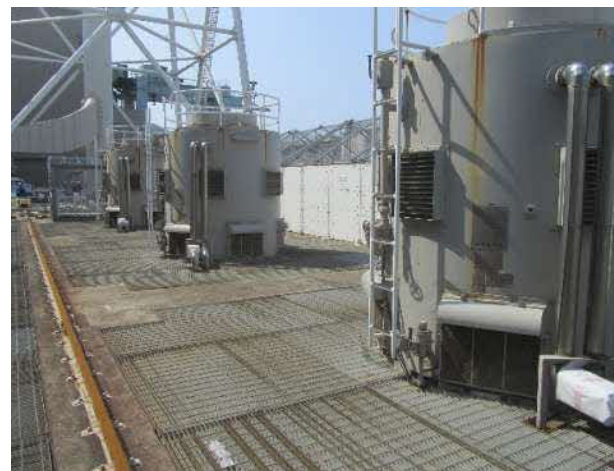
放射線管理区域外にある役目を終えた設備の解体撤去 (循環水ポンプの撤去【今年度実施予定】)
