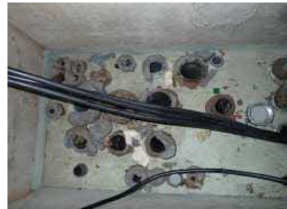
放射線管理区域外にある役目を終えた設備の解体撤去 (中央制御室制御盤、床下貫通ケーブルの撤去【完了】)
