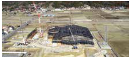
整備が進む新体育館
