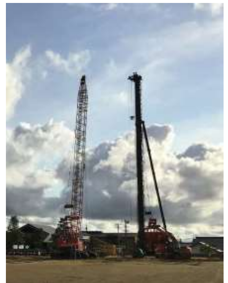
（左側）クローラークレーン （右側）杭打機
