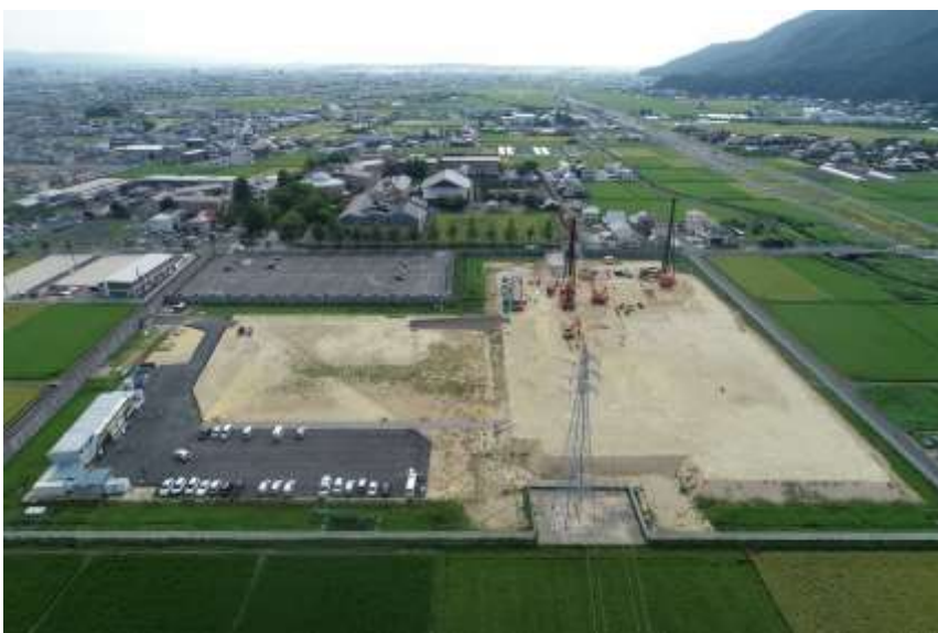
敷地東側上空からの現場写真（令和4年8月29日現在）
