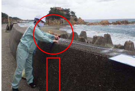
削孔間隔を確認している状況写真
