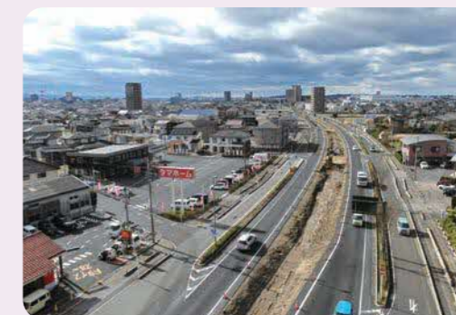
国道9号バイパス(川跡地区周辺)
