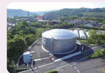
向山第1配水池
