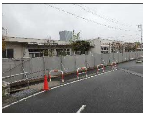
(敷地西側以外の仮囲いイメージ) シート張 H=1.8m
