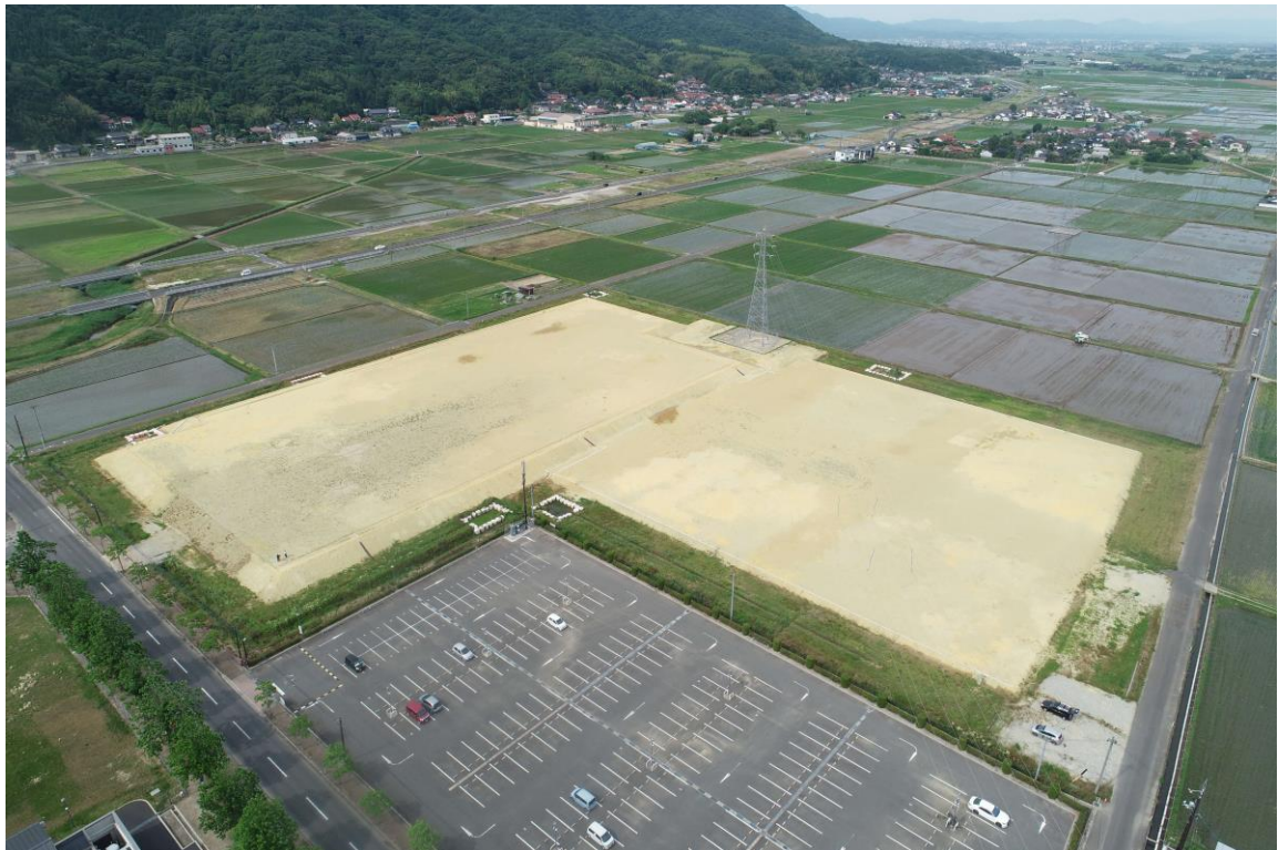
【新体育館建設地（令和4年6月）】
