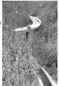
ループ橋除雪中▶
