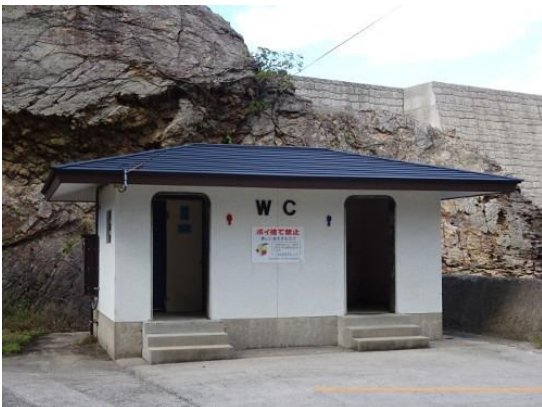
地区内の未改修のトイレ
