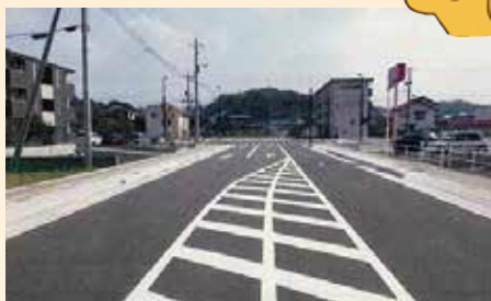
下沢高西線（2工区）
