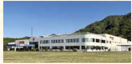
出雲工場の外観
