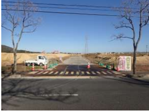
【写真④】 ※工事車両出入口
