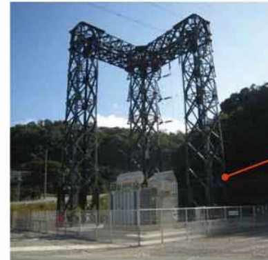
「外部電源の強化」のための耐震性の高い受電設備
