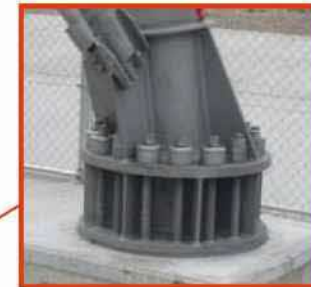
「緊急時の情報通信ネットワーク」のための耐震性の高い通信設備
