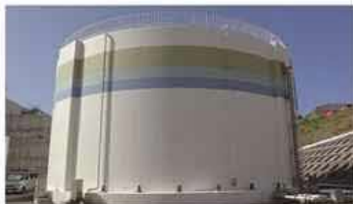
非常用過水タンクの追設
