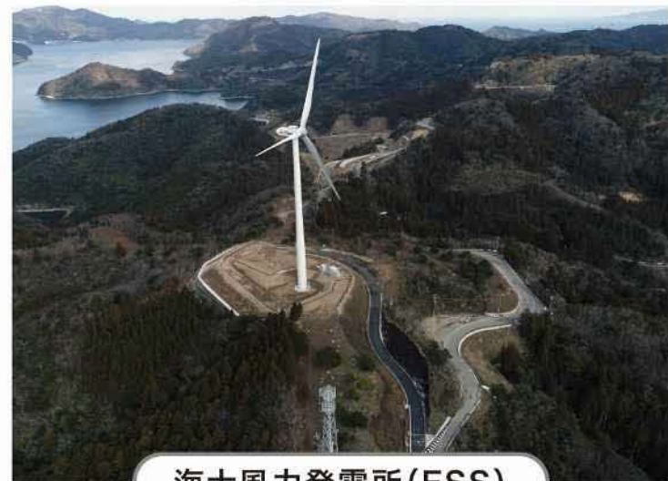
海士風力発電所(ESS)
