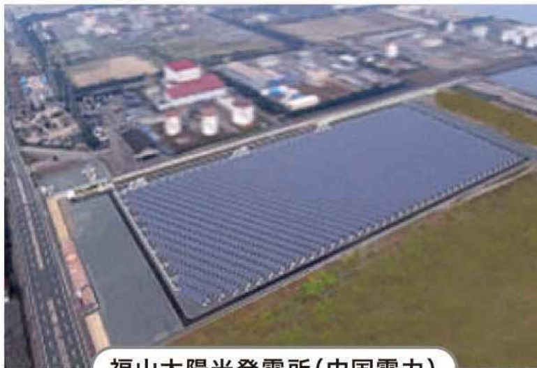
福山太陽光発電所(中国電力)
