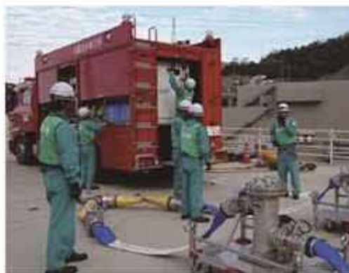
大量送水車を用いた送水訓練
